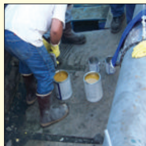
7) mix epoxy resin
