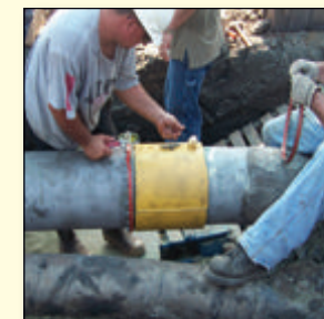
11) remove steel mold
