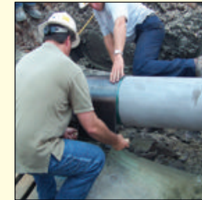
5) apply carbon fiber wrap
