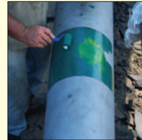
4) apply di-electric primer
